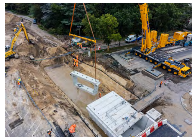
Plaatsing tunnel tussen de Kromme-Rijnlaan en De Dreef
